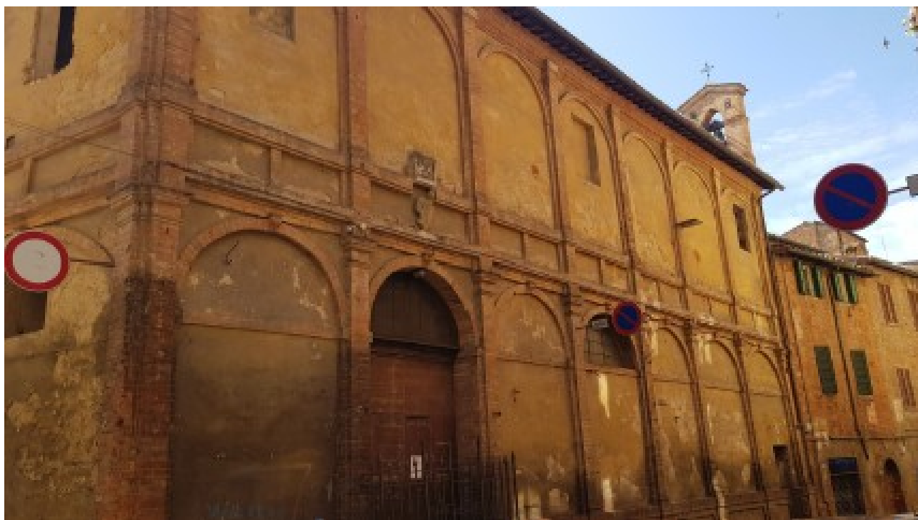
Facciata ad arcate tamponate
